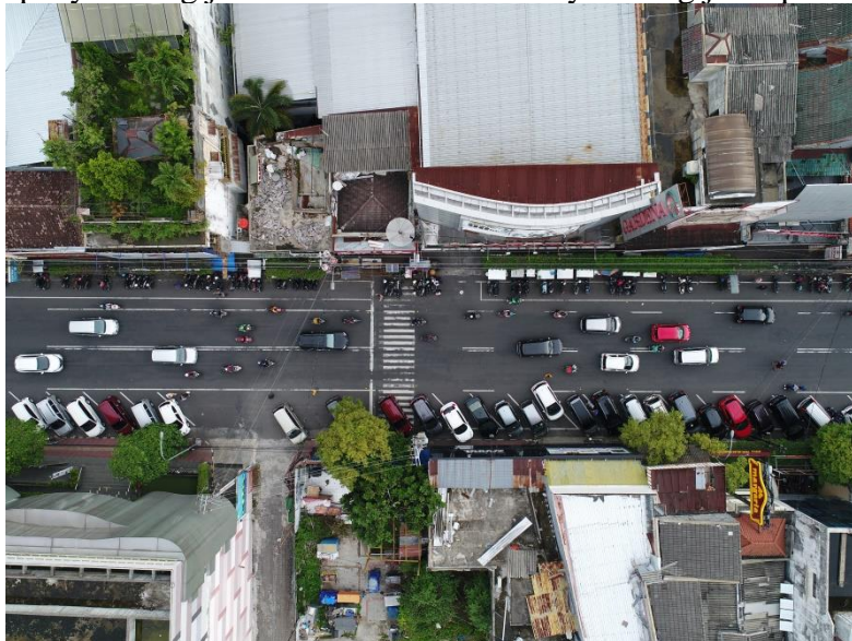
Gambar 2. Kondisi Eksisting dari Udara
